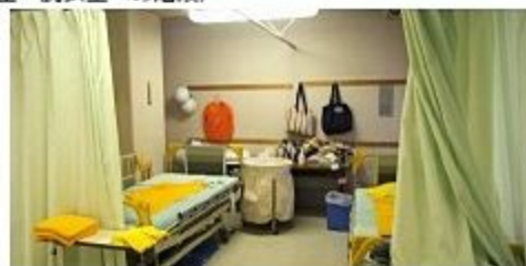
改修前の休憩室
