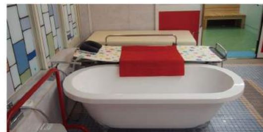
機械浴に代わる浴槽の洋式バス—スライディングシートを用いて
