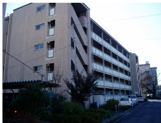
エレベーターのない5階建の都営下馬2丁目団地立替え工事が一部始まっている
